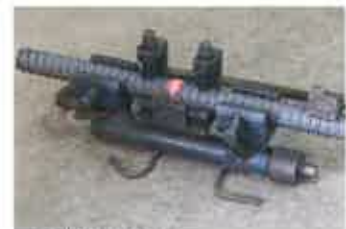
⑤ 溶接施工完了
